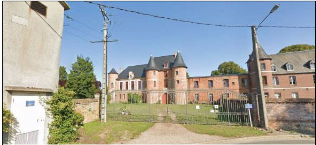
Figure 13 Entrée du château de Beaucamps
